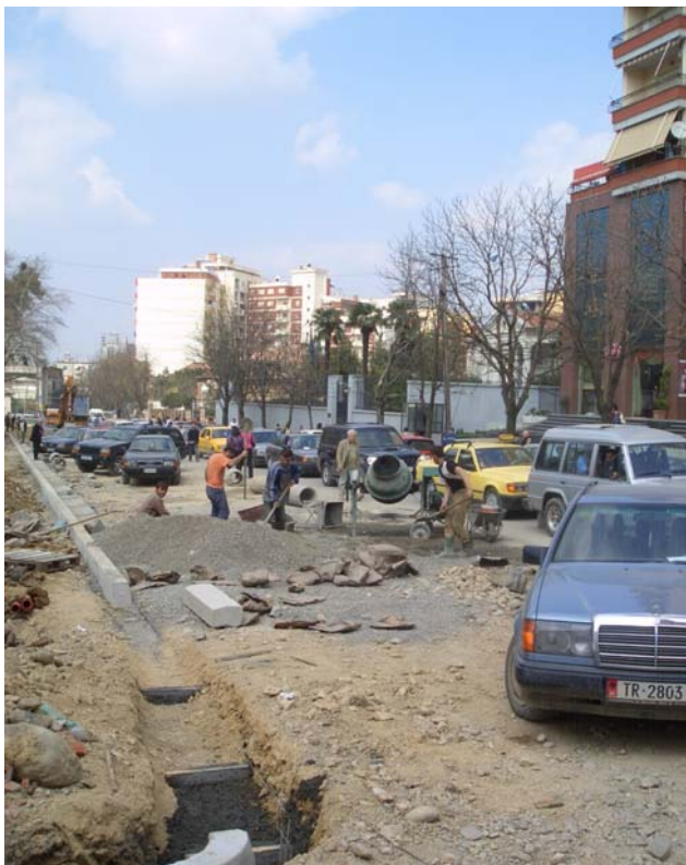
Straßenbau in Tirana
