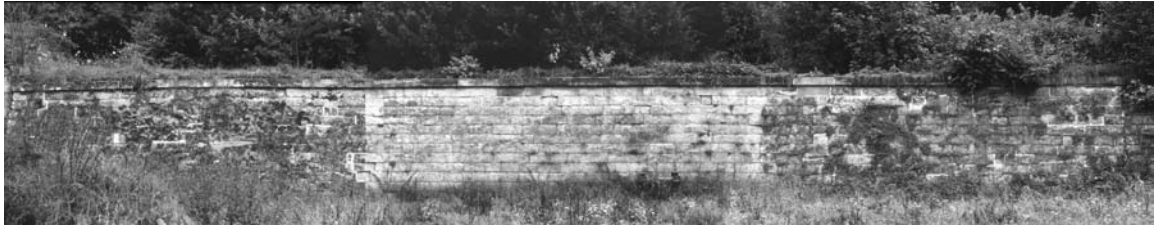
Abb. 4: Kronach, Festung Rosenberg. Musterfläche am Waffenplatz Philipp nach der Fertigstellung im Jahr 2001. In der Bildmitte ist die Komplettsanierung zu sehen, links davon der naturverträglich sanierte Mauerabschnitt, rechts eine Kompromisslösung (Bewuchs mit Mauerzimbekraut).
