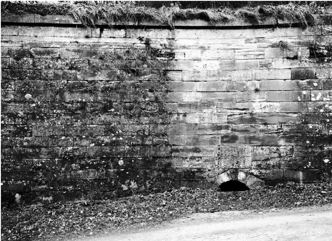
Abb. 3: Kronach, Festung Rosenberg, Ravellin Anton. In der Bildmitte erkennt man die Musterfläche von 1993. Diese Fläche wurde abgeflammt, mit Fungizid behandelt, gefestigt und verfugt. Von 1999 bis heute zeichnet sie sich durch einen flächenhaften Belag mit einer Flechtenart aus ( Lecanora dispersa ).
