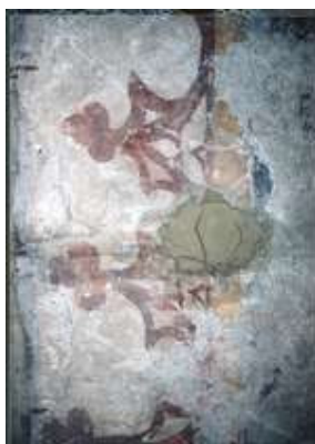
Putzausbrüche, Mörtelflecken
