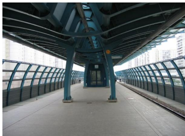
U-Bahn, sondern wurde in Form einer adaptierfähigen Hochbahn konstruiert. Hervorsticht sie durch ihre günstige und auf Nützlichkeit fixierte Bauweise.
