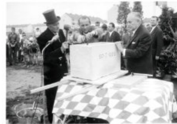
Am 20. Juli 1962 fand die Grundsteinlegung für den Neubau der Pädagogischen Hochschule statt, dem heutigen Standort in der Feldkirchenstraße.
