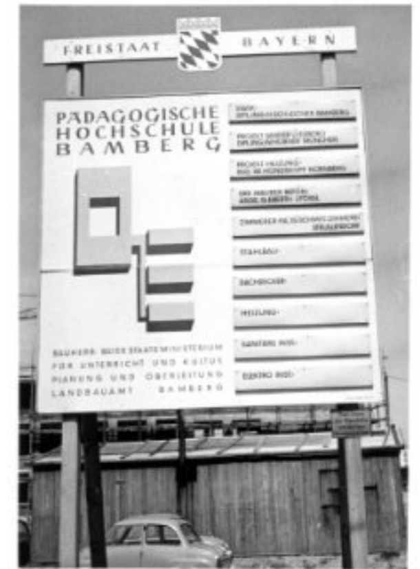
Der Neubau der Pädagogischen Hochschule sollte die Raumnot lindern.
