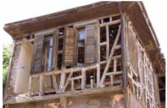
Abbildung 4: Vorbereitung zur Renovierung? (2006)
