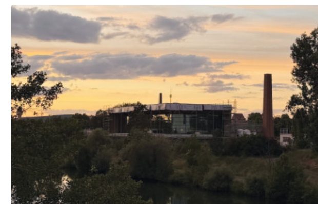
Das neue Universitätssportzentrum befindet sich gerade mitten im Bau. Auch hier wird Nachhaltigkeit im gesamten Bauprozess mitgedacht. So bekommt das Gebäude beispielsweise eine PV-Anlage.
