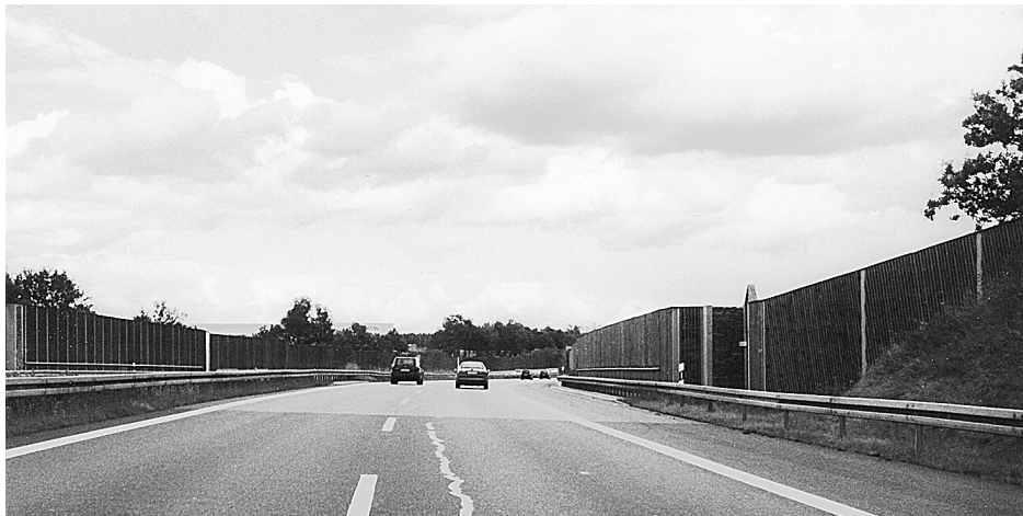
Abb. 4: A 72 Hof-Chemnitz bei Zwickau nach Ausbau (2005)
