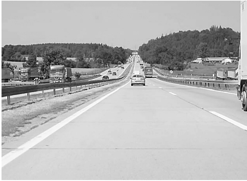
Abb. 6: A 9 München-Berlin zwischen den Anschlussstellen Schleiz und Dittersdorf 2007
