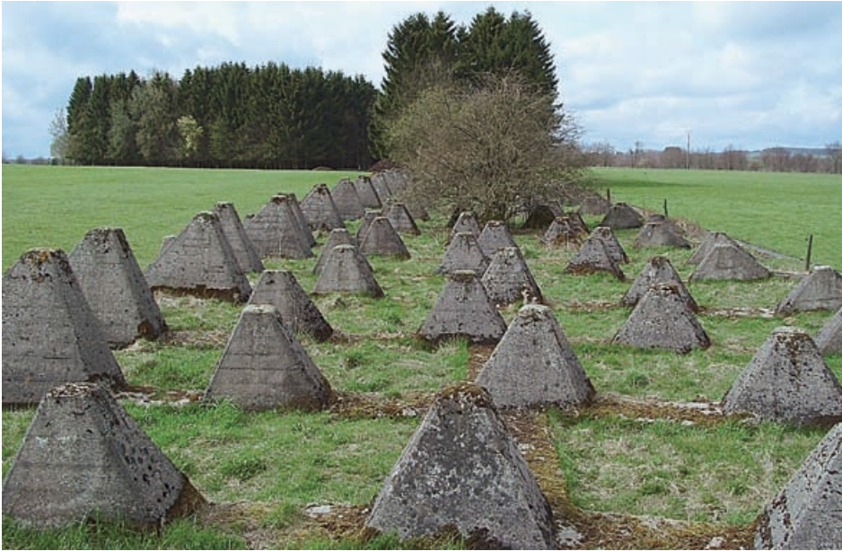
Abb. 3: Fünfüßige Panzersperre („Drachenzähne“) des „Westwalls“ bei Simmerath in der Eifel
