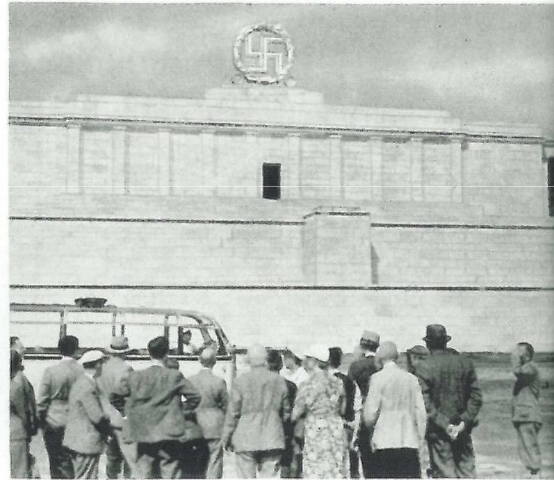
Besichtigung der neuen Parteitagbauten auf dem Zeppelfeld.
