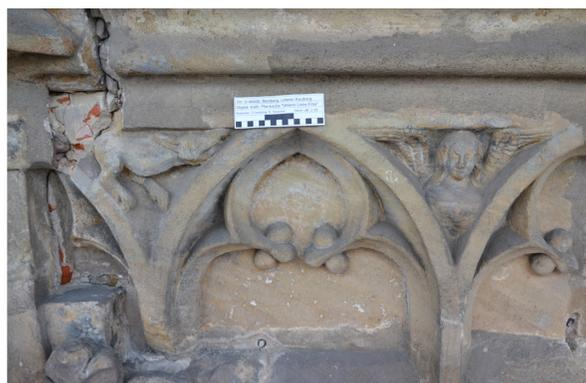
Abb. 3 Blendarkadenabschlussfries mit figürlicher Ausgestaltung der Zwickel und massivem Riss, Czwiolong/Tenschert 2014.
