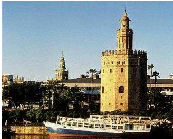
Torre del Oro, Sevilla
