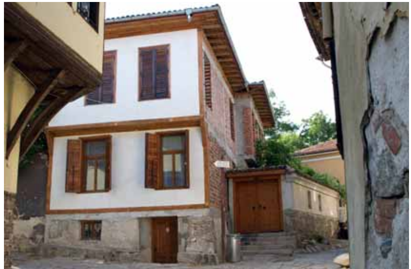
Abbildung 6: Haus fertig, fast ganz verputzt (2009)
