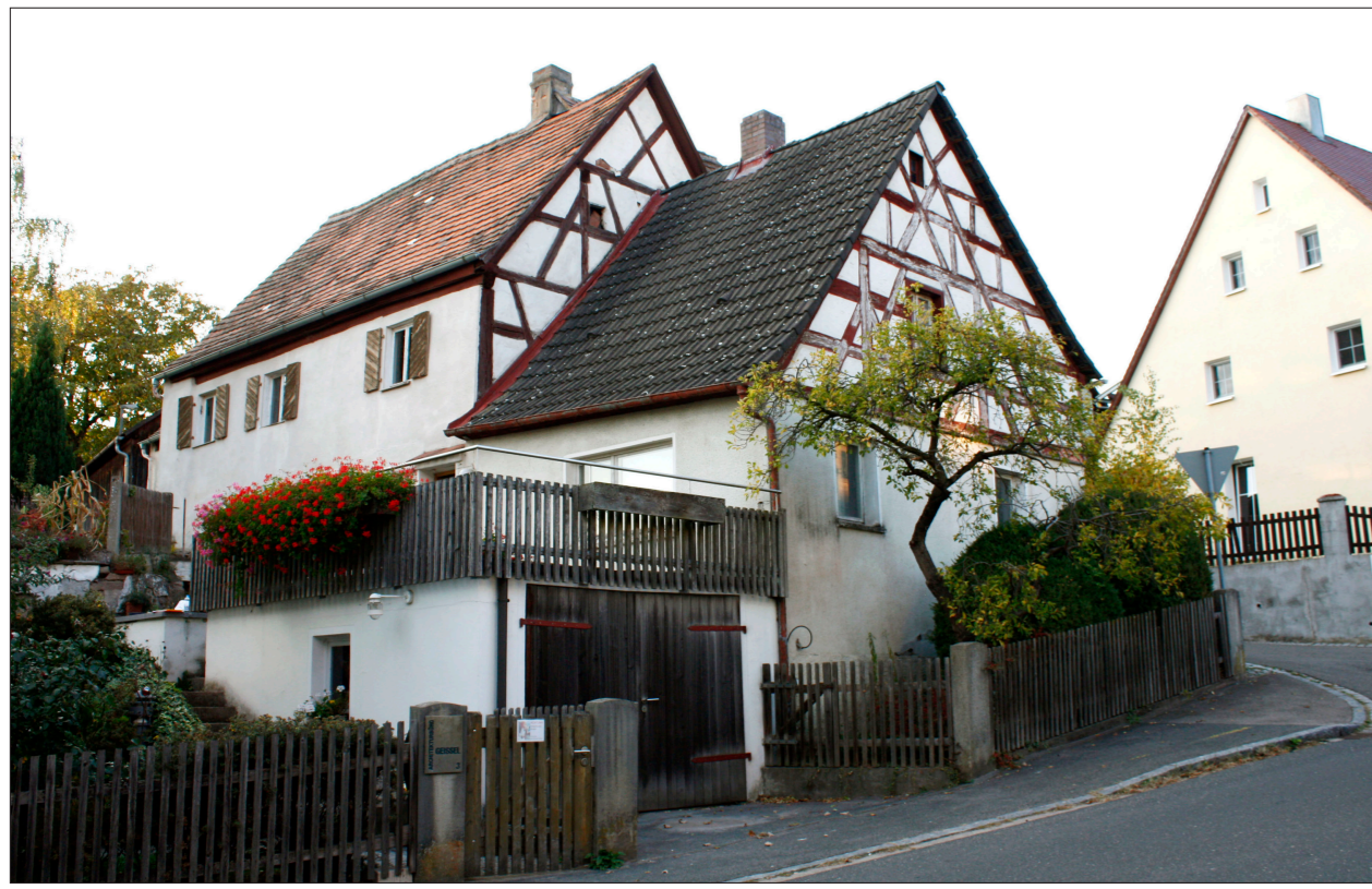
Abb. 1 Ansicht Südosten von Güssübelstraße aus, Geißel 2016
