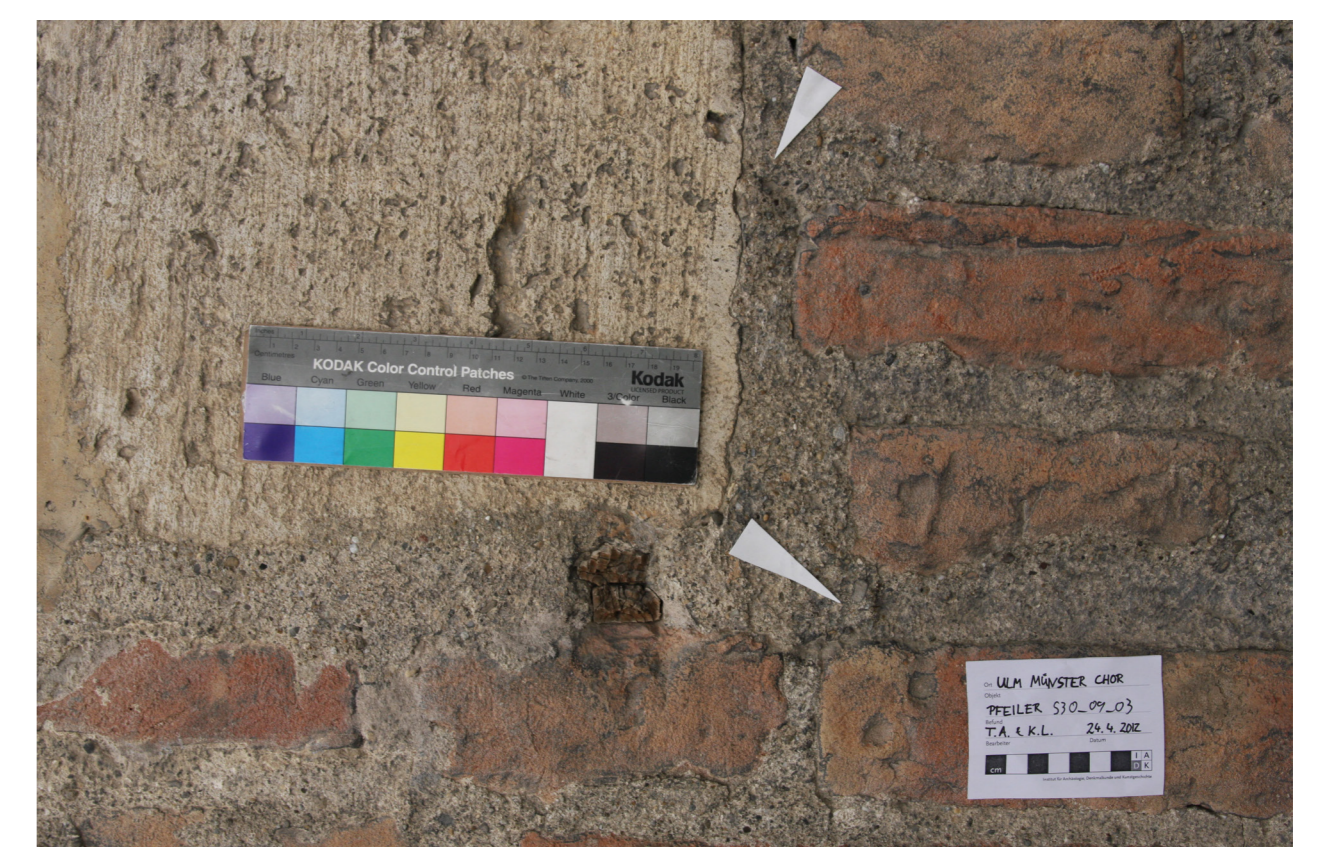
Mörtelgrenzen geben Hinweis auf den Ablauf beim gemeinsamen Aufmauern von Natur- und Backstein im direkten Umfeld der Prophetenfiguren; Hölzchen im Mörtelbett dienten beim Steinversatz zur Nivellierung
