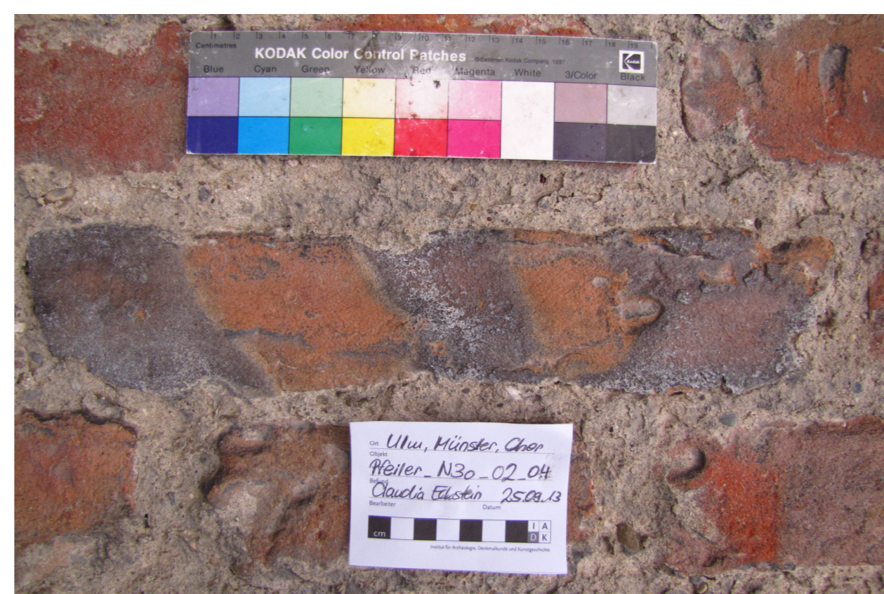
Charakteristische Spuren der Stapelung beim Brand; die Abdrücke ziehen sich diagonal über den Stein; dies zeigt, dass die Steine beim Brand schräg auf den darunter liegenden gestapelt wurden, was gewährleistet, dass die Brenngase in alle Ecken des Brennofens geführt werden konnten
