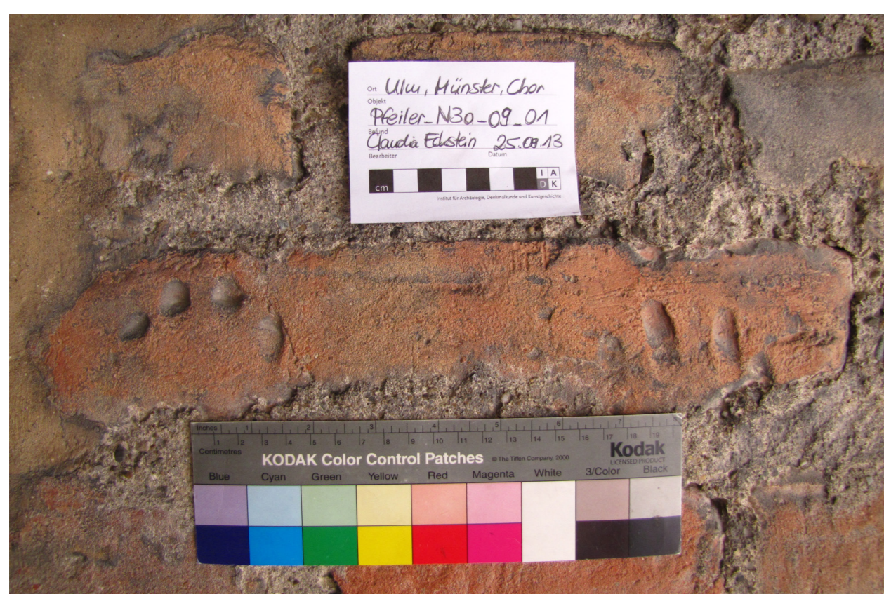
Fingerabdrücke zweier Hände als Relikt des Herstellungsprozesses; können bei dem Wenden und Aufstellen der Steine (Trocknung), beim Herauslösen aus der Form oder beim Einstapeln in den Ofen entstehen
