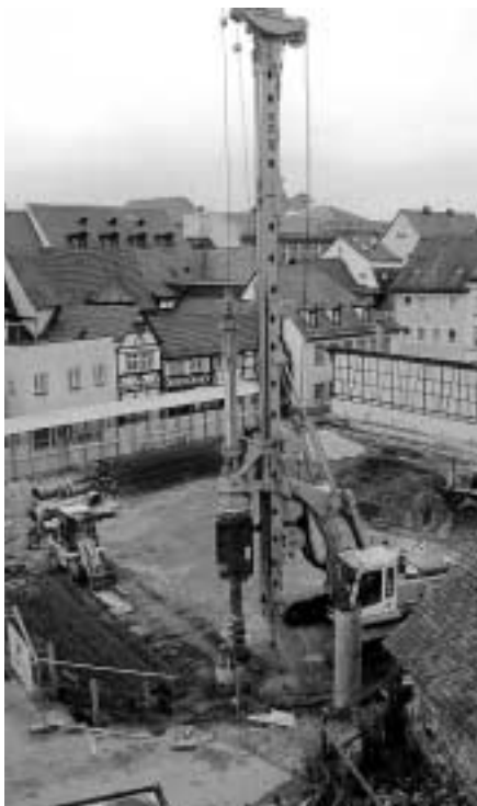
Die Bauarbeiten im Burgershof zur Errichtung der Teilbibliothek Sprach- und Literaturwissenschaften gehen zügig voran. Hier werden Bohrungen niedergebracht, um Betonpfeiler (Bohrpfahlwand) einzugießen, die das äußere Erdreich abstützen sollen. Foto: GB
