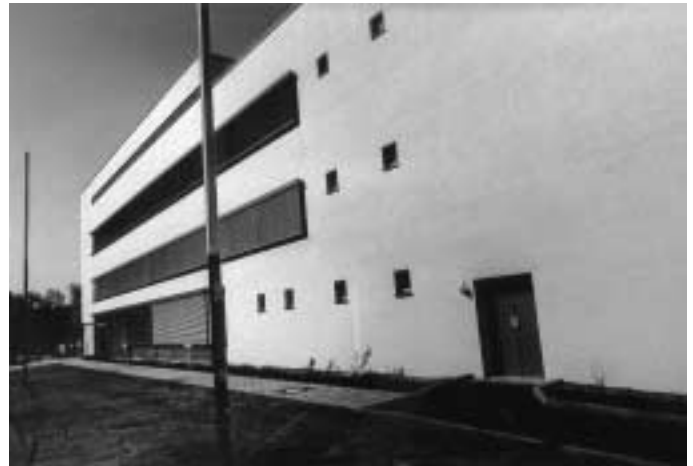
Fassade des neuen Rechenzentrums Feldkirchenstraße 23 mit zwei der drei Stelen als Kunst am Bau
