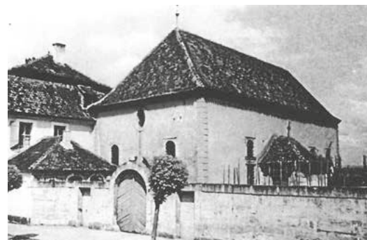
Das einstige Gemeindezentrum. Links im Anschnitt das Rabbinerhaus, rechts daneben die Synagoge und davor in der Mitte die Mikwe – das Tor in der Friedhofsmauer als Zugang zum Friedhof.
