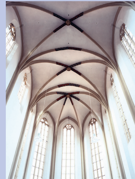
Das 600 Jahre alte Dachwerk über der AULA zählt zu den bedeutendsten der Region.
